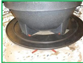
Bewehrungsstahl,  $\varnothing$  16 mm, 1500 mm lang, unter der Ankerplatte aus Polyethylen
