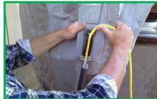
3.) Den Schlauch in den unteren Teil der Seilklemme einsetzen.
